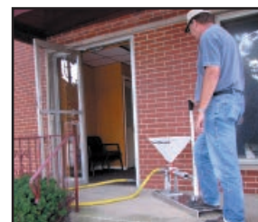
Filling Door Frame
