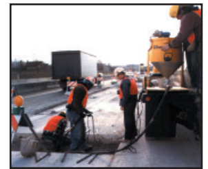
Sửa chữa đường xá
