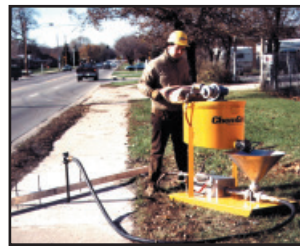
Gia cố sàn, nền móng
